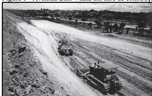
Figura 1 - Avenida Luís Viana em fase de construção
