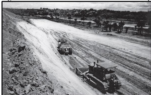
Figura 1 - Avenida Luís Viana em fase de construção
