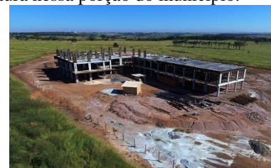
Figura 3: Obra de construção do prédio da UFG, campus da cidade de Aparecida de Goiânia. Fonte: UFG.
