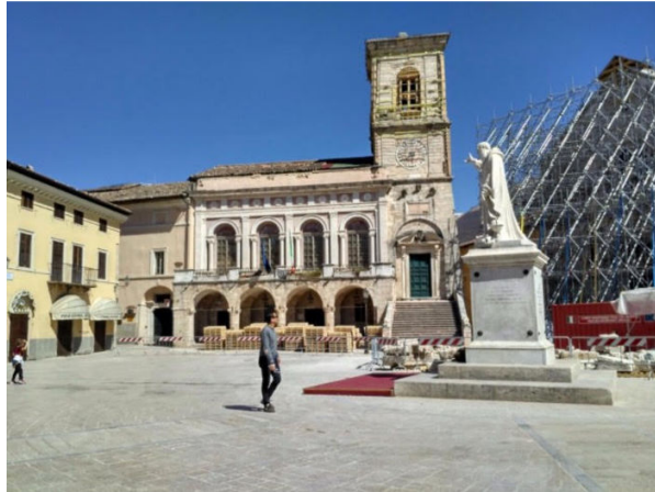
Figura 2: Construção atingida pelo terremoto datada do Período da Idade Média. Fonte: Autores
