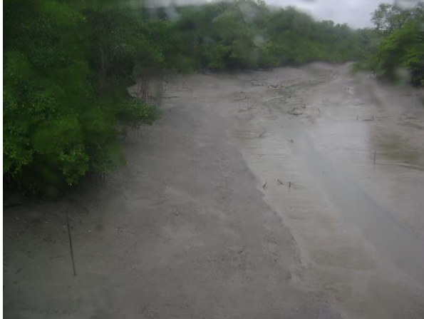
Fig. 3 - Sistema de drenagem do manguezal comprometido pela estrada Bragança-Ajuruteua. Fonte: O autor, 2012.
